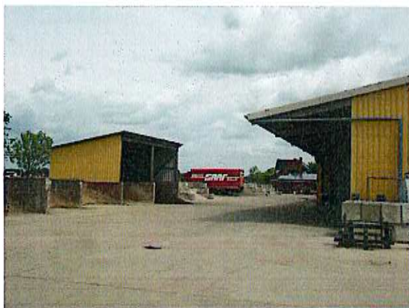
Abb. 3 Blick auf die Betriebsflächen des im B-Plan Nr. 4 ansässigen Gewerbebetriebes mit der vorhandenen Halle rechts im Bild und die Schüttboxen zur K 63
