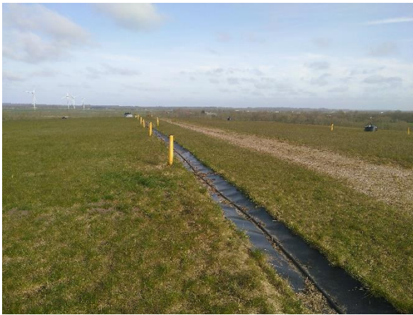
Foto 1: Kuppenbereich mit Schotterweg und Gasbrunnen.
